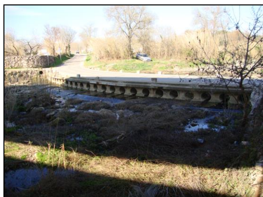
Camí asfaltat amb gual sobre el Manol
