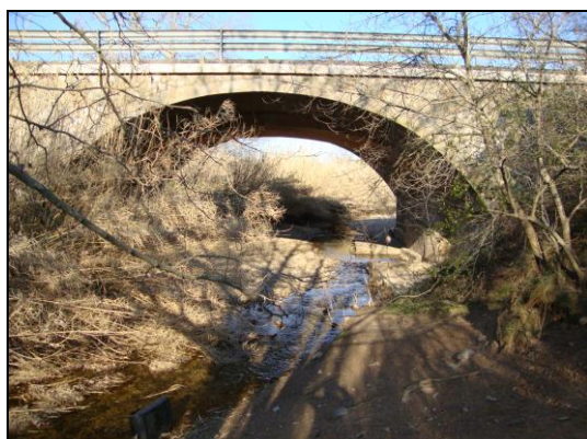
Viaducte de la N-II sobre el Ricardell
