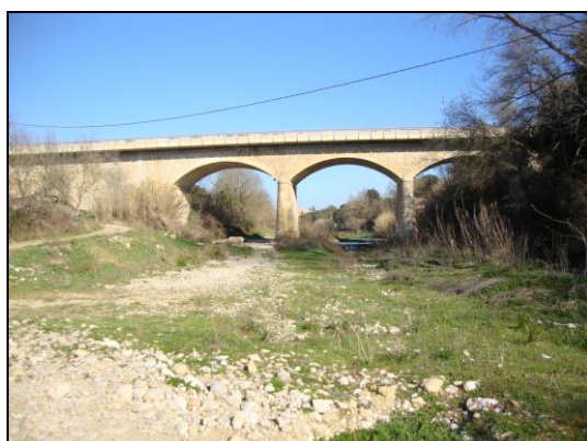
Viaducte de l'A26 sobre el Manol
