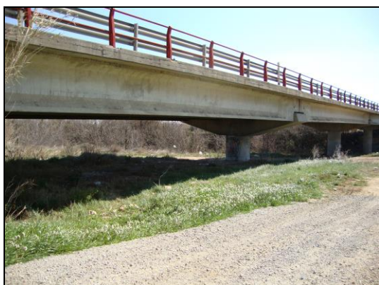
Viaducte de la N-II sobre el Manol
