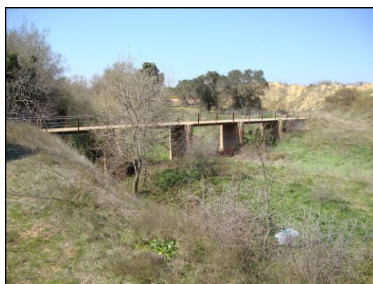
Pont per a vianants sobre el Manol
