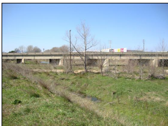
Viaducte de la N-IIa sobre el Manol
