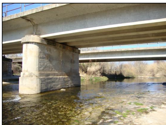
Viaductes de la N-260 i del tren sobre la Muga
