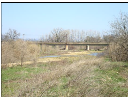
Viaducte del tren Barcelona-Portbou sobre el Manol
