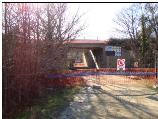
Viaducte de l'AP7 sobre el camí cap a Bosquerós
