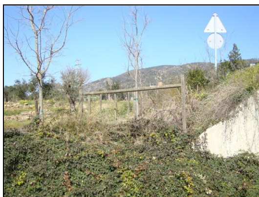
Tancament perimetral a l'entrada d'una OD
