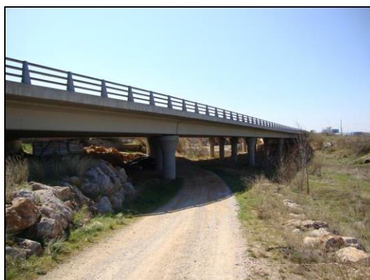
Viaducte de l'A26 sobre el Manol
