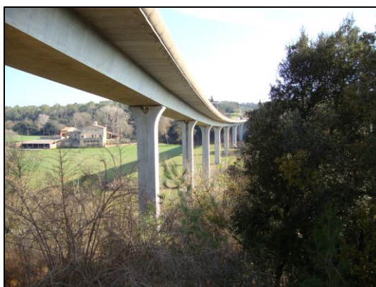
Viaducte de l'A26 sobre la riera de Sant Jaume
