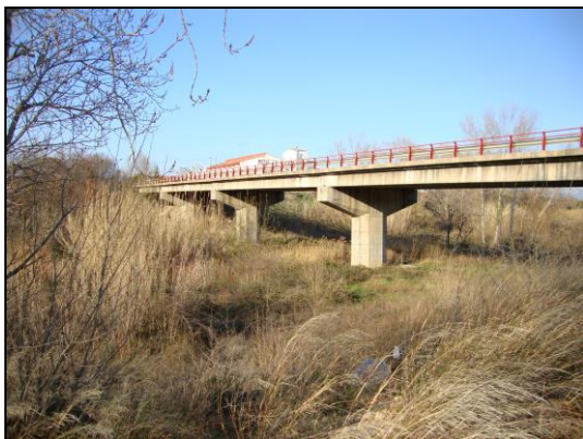
Viaducte de la N-II sobre la Muga
