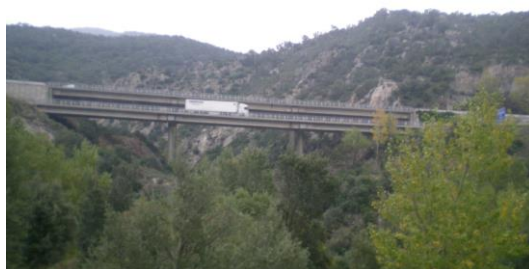
Viaducte de l'AP-7 sobre el Llobregat
