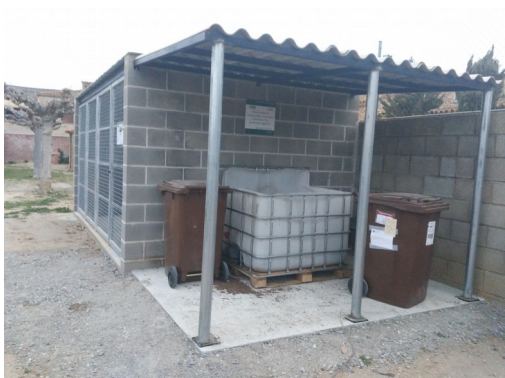
Zona d'emmagatzematge de compost a Viladamat
