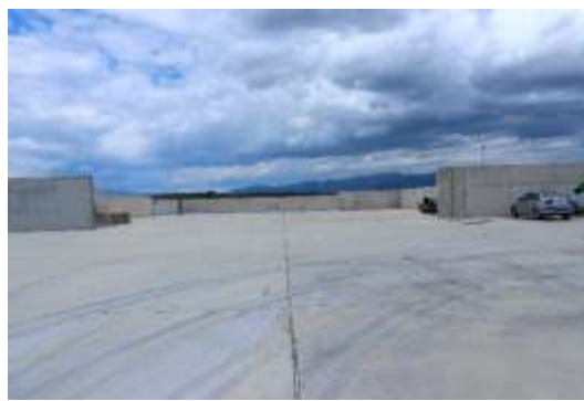
Foto de la futura planta de tractament de voluminosos
